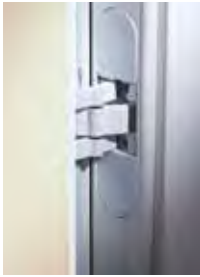
Particolare cerniera a scomparsa Concealed hinge detail
