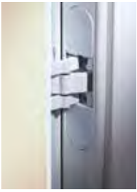
Particolare cerniera a scomparsa Concealed hinge detail
