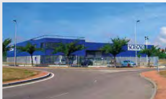
Scrigno France, sede di Montceau-les-Mines Factory in Montceau-les-Mines France
